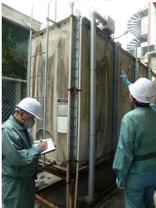
<無料巡回点検の様子>
