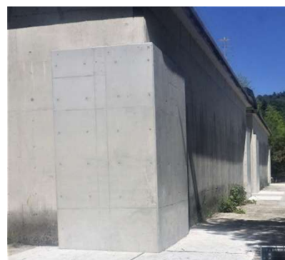
【構造物の耐震補強（藤の木調整池）】
