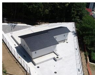
【施設の更新・改良(別所調整池)】
