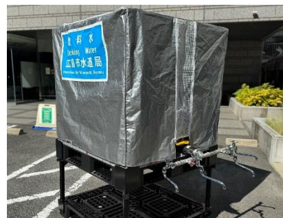
【応急対策の推進(仮設水槽)】
