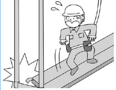
足場の組立工事で足場上を歩行中、足場板のツメが破損して板が傾き、バランスを崩して転落しそうになった
