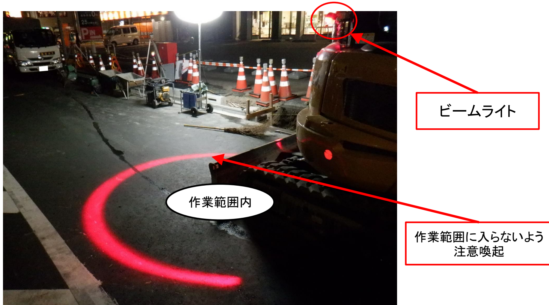
【重機に取り付けたビームライトで、重機作業範囲を照らしている状況】
