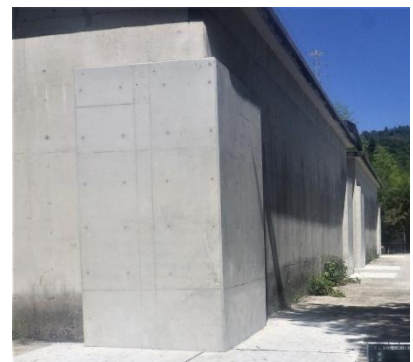
【構造物の耐震補強（藤の木調整池）】
