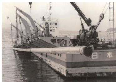
昭和42年（1967年） 似島海底送水管の布設工事
