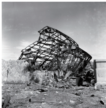
壊滅した 水道部庁舎
