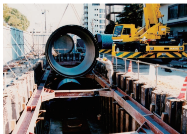
平成期の配水管布設工事
