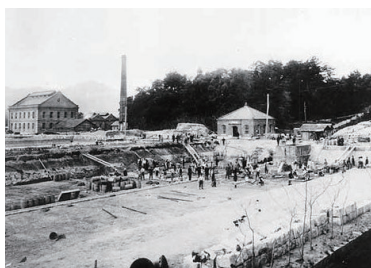
明治40年（1907年） 牛田濾過池の築造工事
