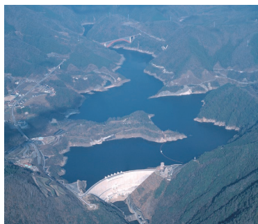
平成 14 年（2002 年）完成 温井ダム
