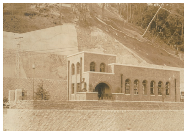
昭和10年（1935年） 己斐調整場ポンプ室
