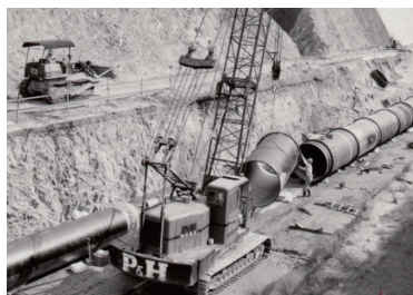
高度経済成長期の配水管布設工事
