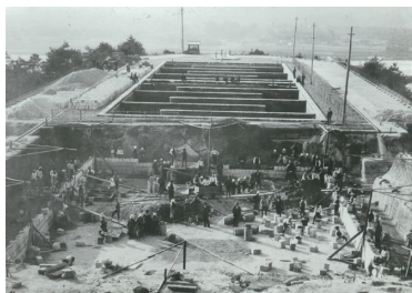
明治40年（1907年） 牛田配水池の築造工事
