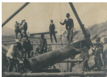
創設期の配水管布設
