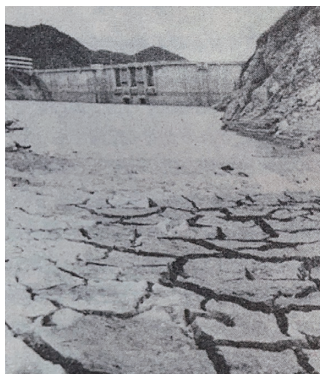
平成 6 年大渇水 (広島県土師ダム) 【広島県提供】
