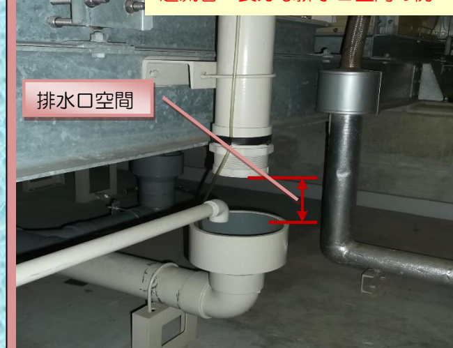
越流管 良好な排水口空間の例
