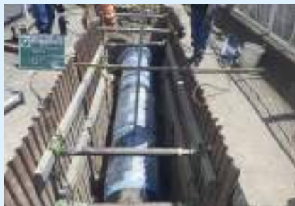
中・大口径管路の更新工事
