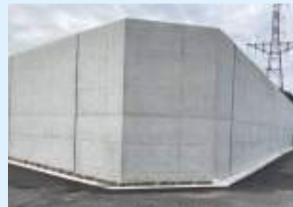
高陽取水場浸水防止壁
