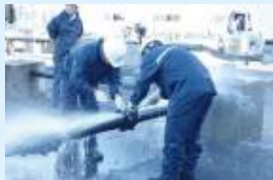
水道管の漏水対応研修
