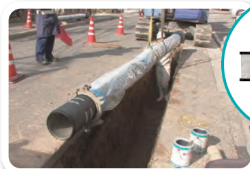
▲水道管の取替工事
