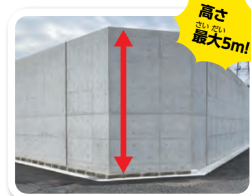
▲高陽取水場の防水壁
