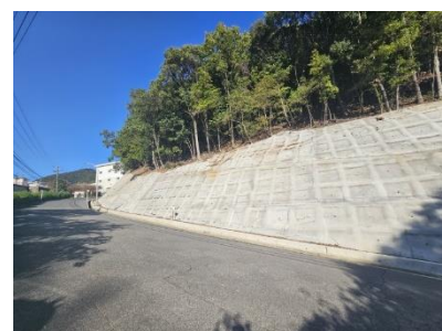
【土砂・浸水災害対策の推進(法面整備)】
