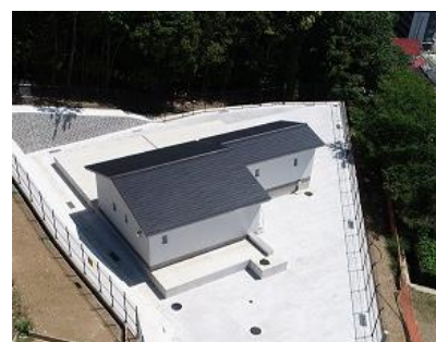
【施設の更新・改良(別所調整池)】
