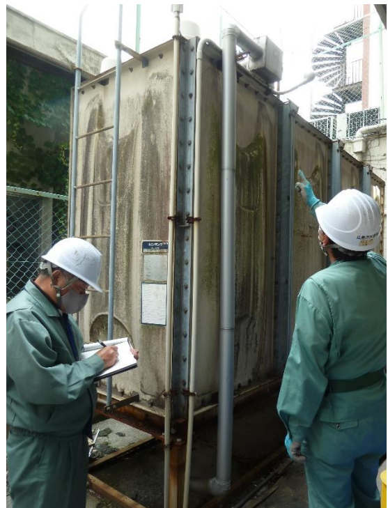
<無料巡回点検の様子>
