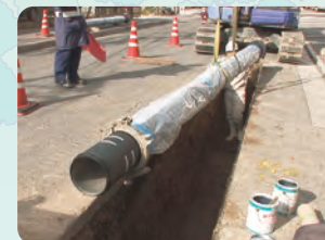
▲取替工事の様子
