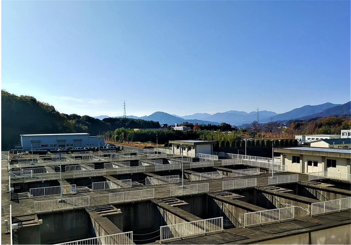
高陽浄水場 ろ過池
