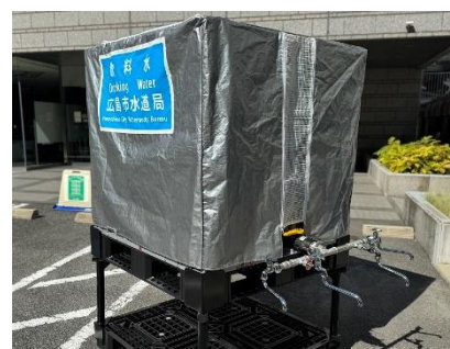
【応急対策の推進(仮設水槽)】
