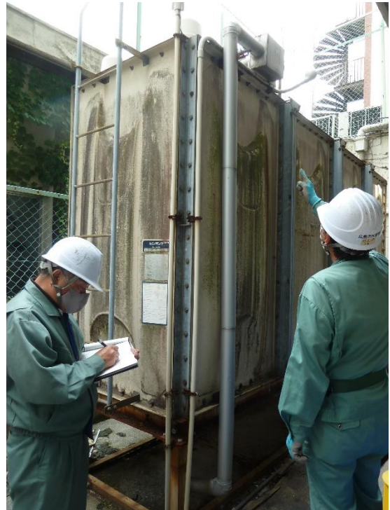
<無料巡回点検の様子>
