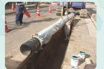
▲取替工事の様子
