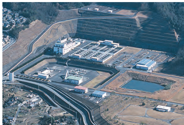
高陽浄水場 Koyo Purification Plant
