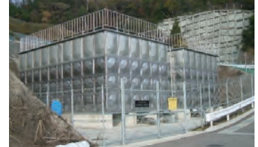
更新した配水池 The renewed service reservoir
