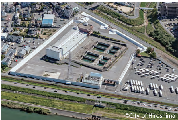
高陽取水場 Koyo Intake Station
