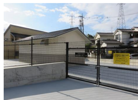
【施設の更新・改良(府中北第一ポンプ所)】
