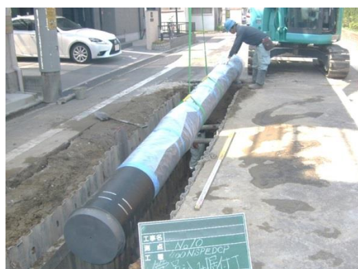
▲ 古くなった配水管を耐震継手管に取り替える工事
