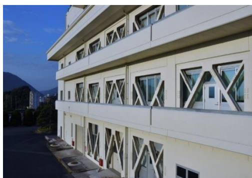
図 3 耐震補強後の高陽浄水場管理棟
