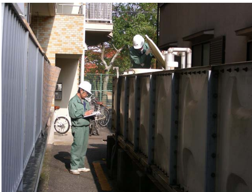
▲小規模貯水槽水道の点検
