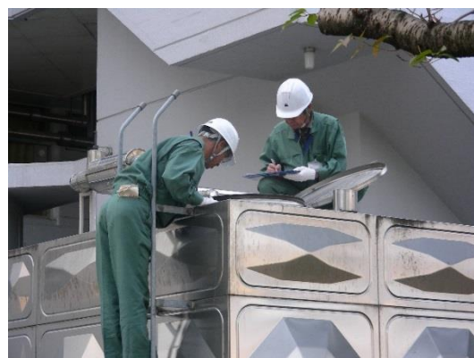
▲ 小規模貯水槽水道の点検
