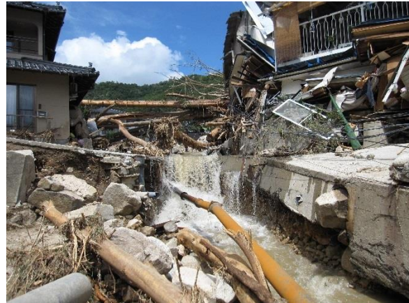
▲ 平成26年8月豪雨災害の状況
