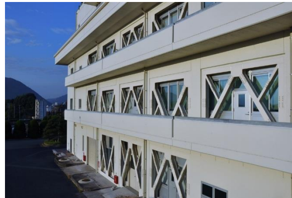
▲ 耐震補強（高陽浄水場管理棟）
