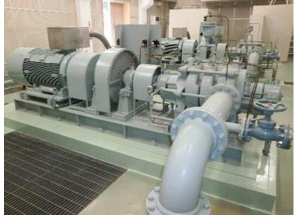
▲ 高効率電動機採用のポンプ設備
